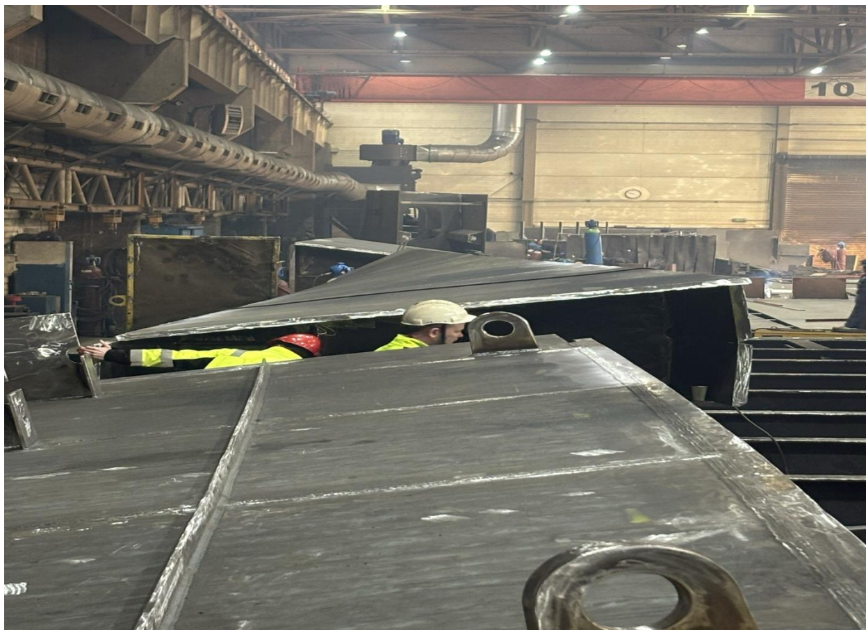
Hala Mostostal Kielce, Polsko — kompletace ocelových dílců na pozici (únor 2026).
